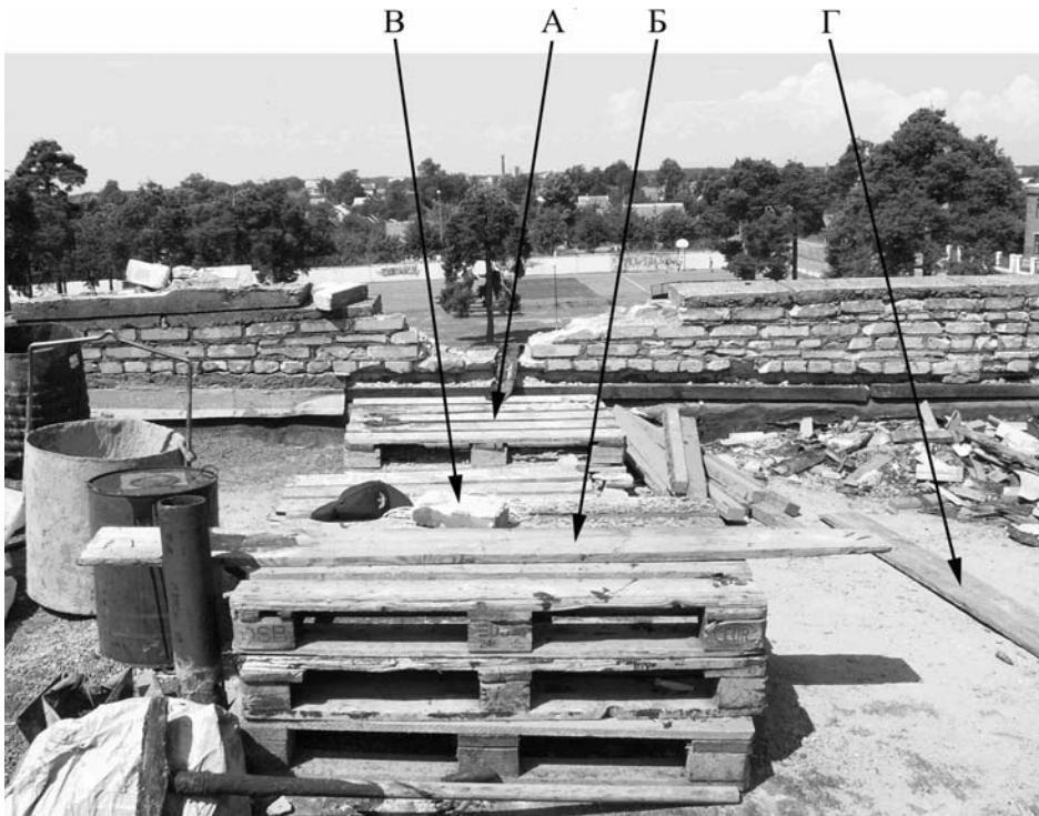
Рис. 1. Вид места установки подъемника на крыше здания
